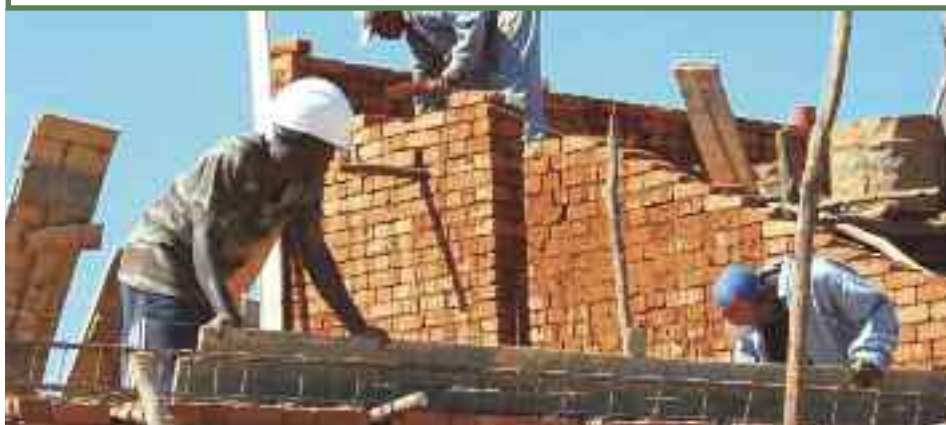
Des travaux d'agrandissement du centre de vie.
